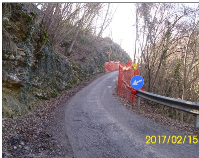
Figura 7 – Panoramica delle due zone, di valle e di monte, oggetto di consolidamento
