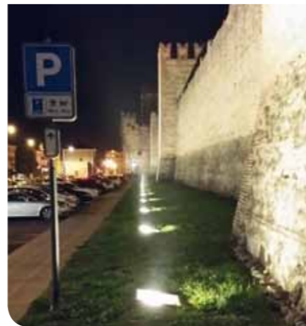
7) Illuminazione delle mura - Illuminazione delle mura di Via Stazione.
