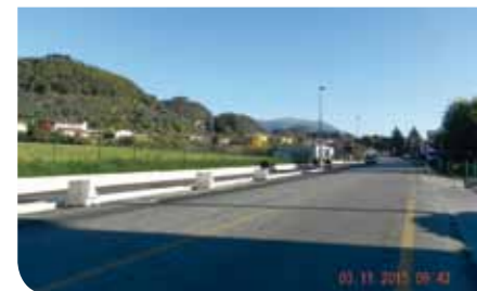
1) Percorso urbano di via Montello - Ultimata la realizzazione di tre tratti consecutivi del percorso urbano che vanno dall'intersezione con via Cavallara - Levà fino all'intersezione con via Canale in direzione Bassano. Il percorso è stato completato con un nuovo impianto di illuminazione a led e con la posa dei cavidotti necessari alla futura posa di una linea di fibra ottica. Conte-
