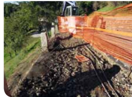
2) Frana in via Cansignorio - Ripristino cedimento
