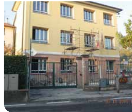
4) Scuola "Virgilio Andriolo" di Valle San Floriano - Intervento di consolidamento nella scuola elementare della frazione.
