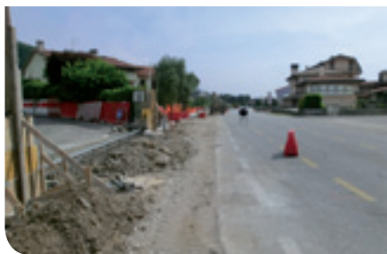
I lavori per il percorso urbano e la fognatura lungo via Montello
