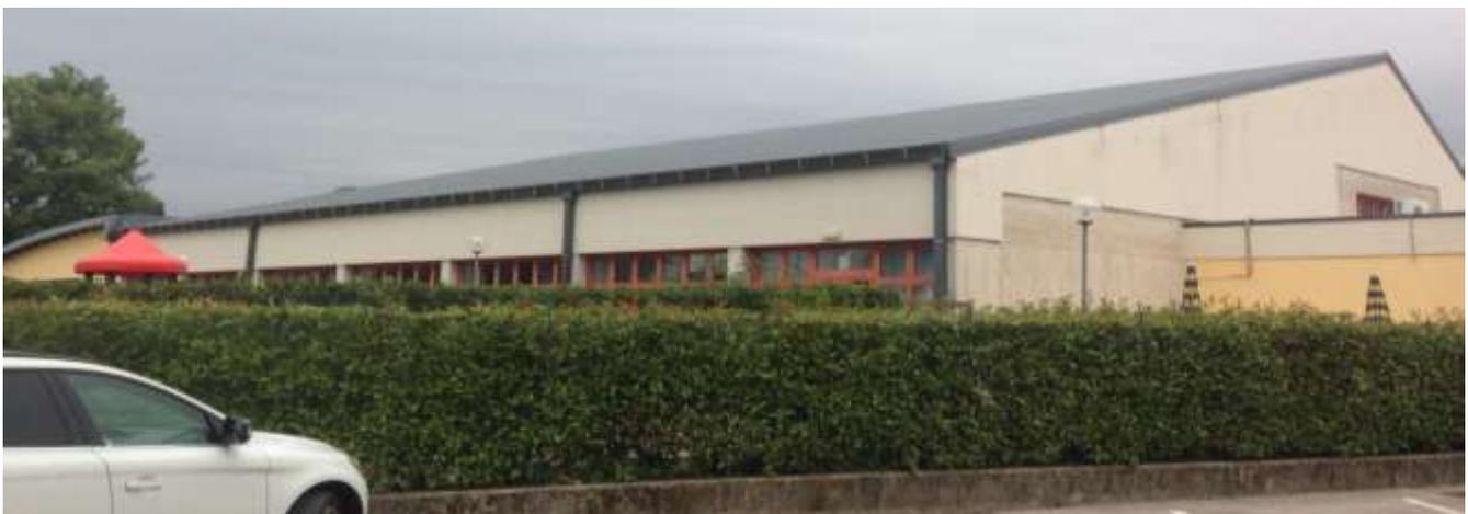
La foto evidenzia la porzione di copertura della piscina di Marostica rivolta verso sud, la quale si presta per l'inserimento di un impianto fotovoltaico così come dimensionato nella variante al progetto definitivo esecutivo. I lavori previsti nel progetto prevedono l'inserimento da subito di un impianto fotovoltaico da 105 KW per abbattere drasticamente i consumi di elettricità.
