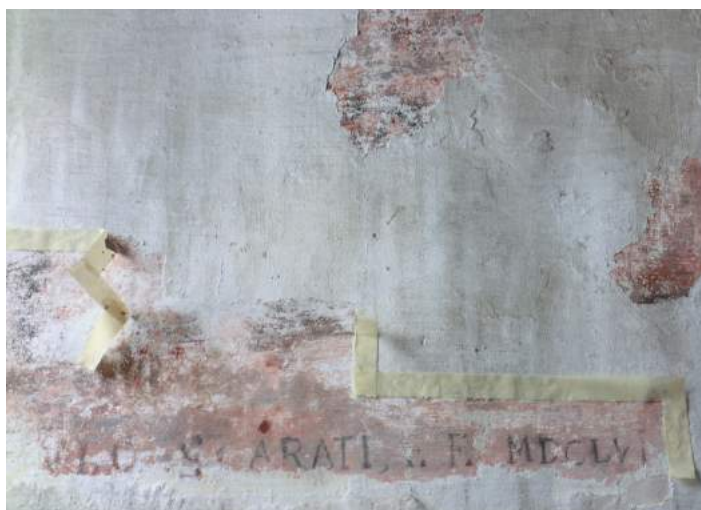
Lo stato di abbandono e degrado in cui erano i locali e, in evidenza, gli strati di intonaco che ricoprivano i dipinti - Ph. Gianni Baron
