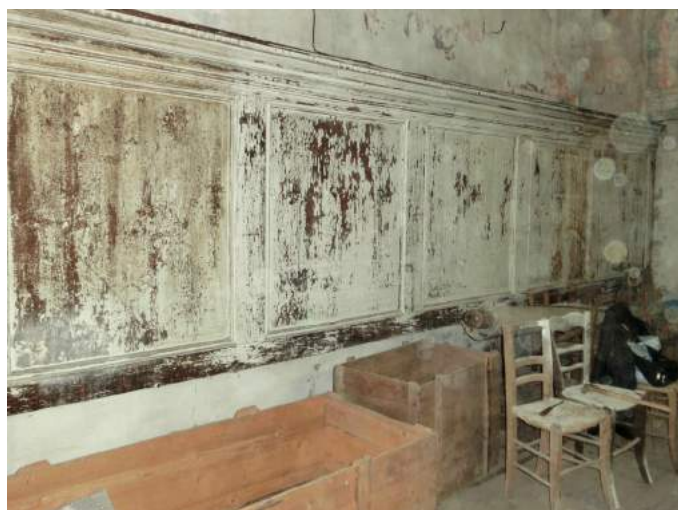
Lo stato di abbandono e degrado in cui erano i locali e, in evidenza, gli strati di intonaco che ricoprivano i dipinti - Ph. Gianni Baron
