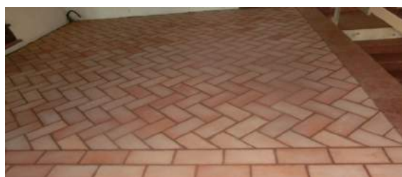
Il nuovo pavimento in larice posto a sud e quello in cotto posto a nord, cos  come all'origine - Ph. Gianni Baron
