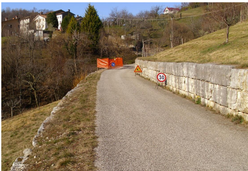
Figura 6 – Foto dell'area di cantiere (via Pedalto Ovest)
