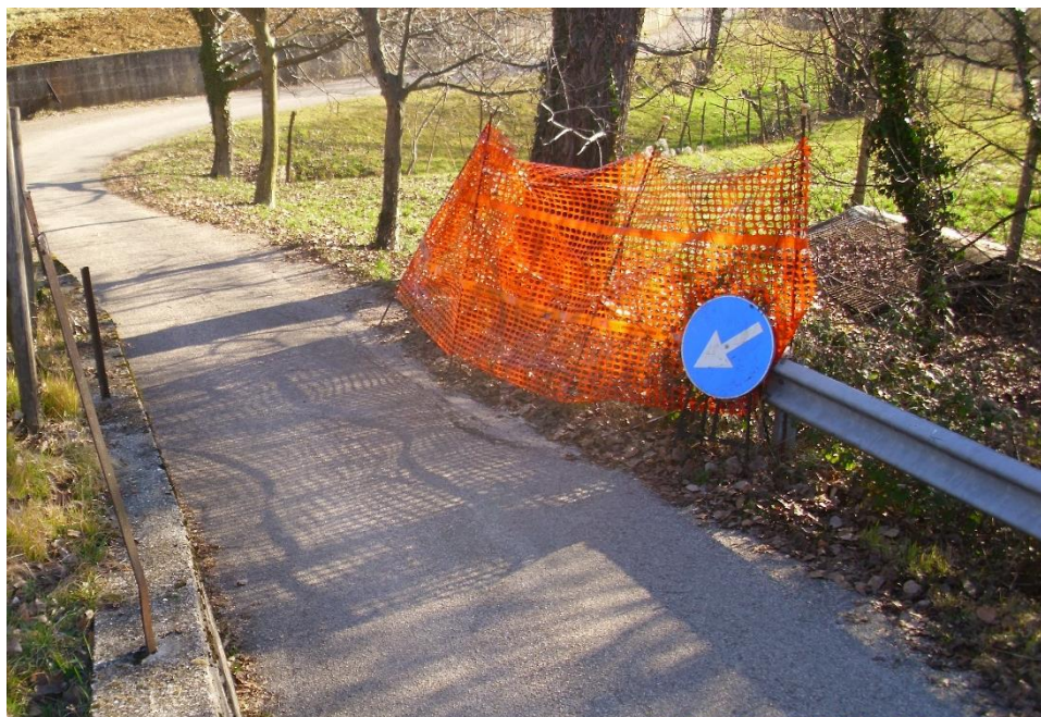
Figura 7 - Foto dell'area di cantiere (via Pedalto Est)
