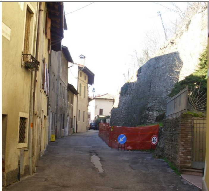
Figura 5 – Foto dell'area di cantiere (via Beato Lorenzino)
