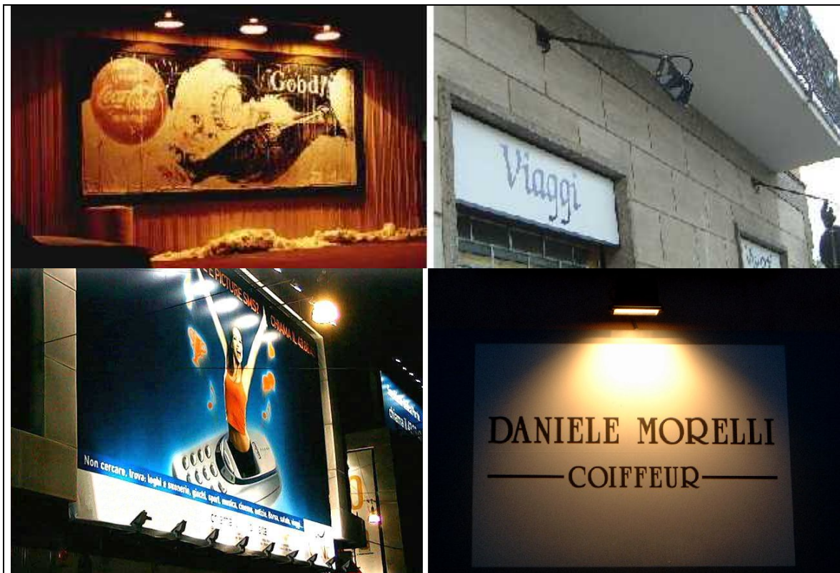
Fig.16 – Alto-Sinistra: Insegna conforme alla L.r.17/09 con emissione di 0\text{cd}/\text{klm} a 90^\circ ed oltre. Alto-Destra: Proiettore inclinato solo in parte schermato dal terrazzo non conforme. Basso-Sinistra: Illuminazione dal basso di cartellone pubblicitario NON conforme alla L.r. 17/09 Basso-Destra: Insegna di modeste dimensioni e illuminata correttamente.
