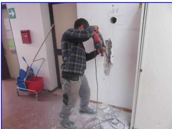
Foto 7: *Rimozione di intonaco e copriferro*
