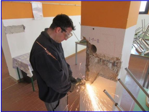
Foto 24: Taglio di una barra di pilastro
