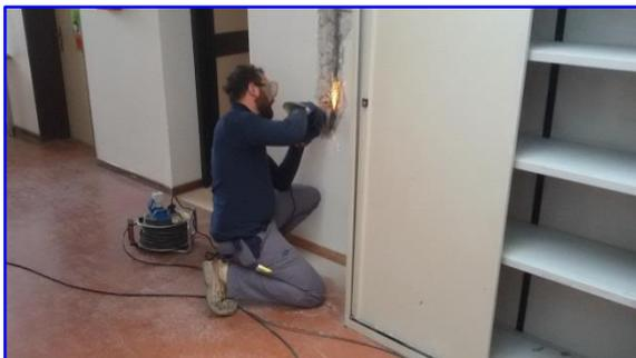
Foto 38: *Smerigliatura armatura su pilastro*
