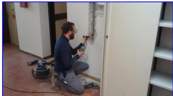
Foto 39: *Acquisizione dei dati su pilastro*
